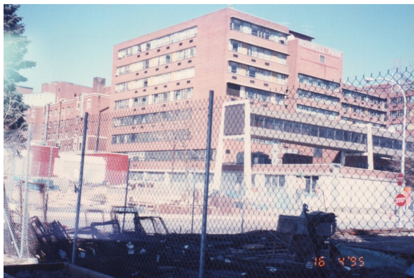
工事中のRoswell Park
